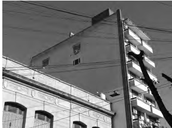
Consorcio Edificio Malvinas, San Martín 3481. Santa Fe. Medianera Sur. Foto: Arq. Hernán Busaniche
