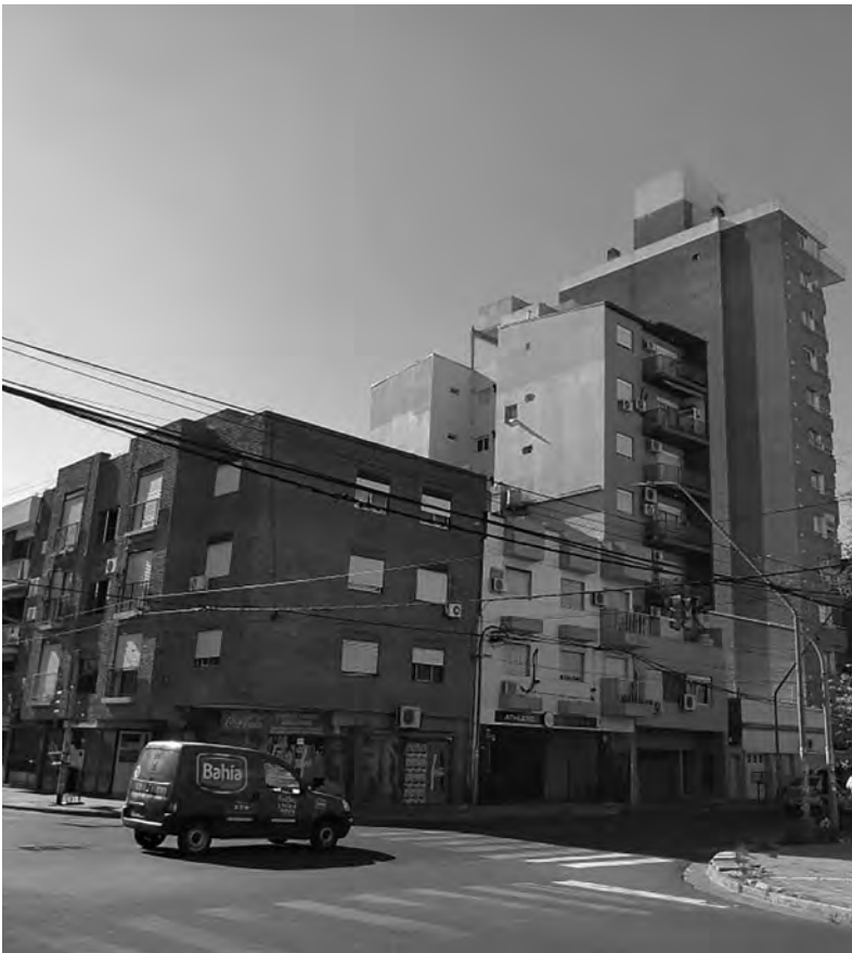
Edificio en 25 de mayo 3280. Muro con ladrillos huecos en baño, posteriormente propietarios avanzan con ventanas en baño y cocina. Foto: Hernán Busaniche
