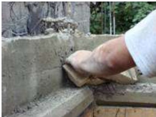
Figura 8 – Colocación de la segunda hilada de BTC
