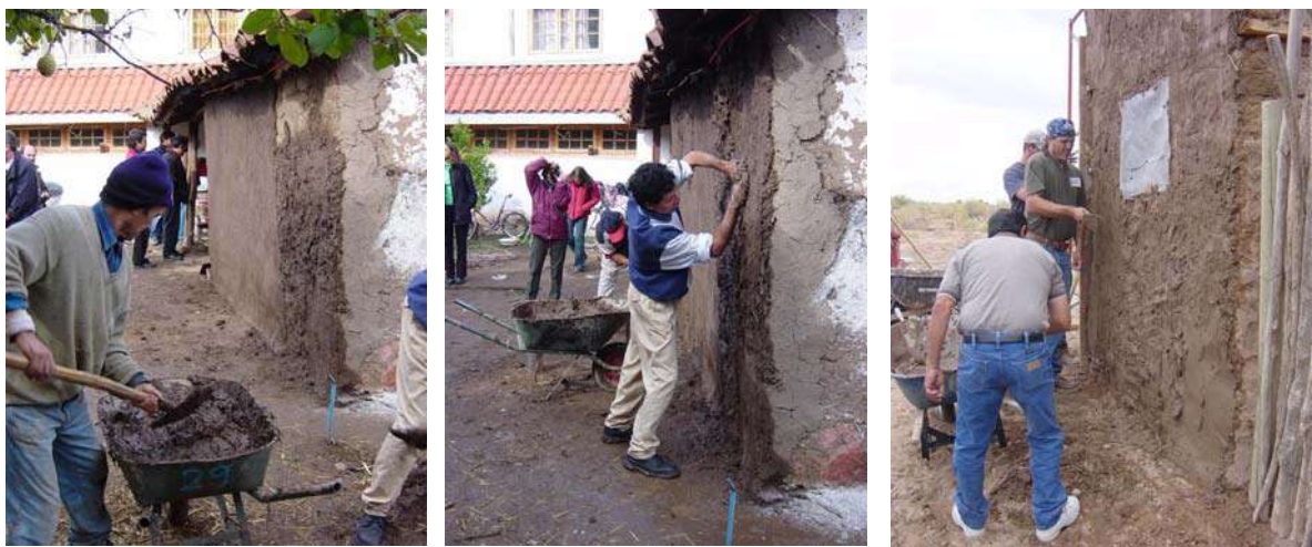
Figura 3 – Mezcla para revoque inicial de barro; aplicación del revoque a mano; aplicación del revoque con cuchara
