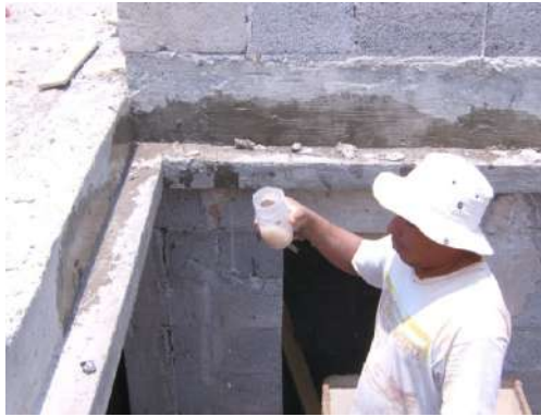
Figura 6 – Proceso de humedecer el área de contacto del BTC
