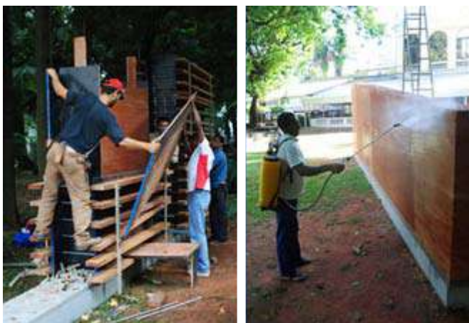
Figura 17 – Desmontaje y curado del panel de tapia estabilizada con cemento
