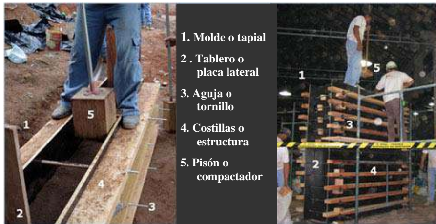
Figura 11 – Moldes desarrollados a partir del proyecto de investigación realizado en el CEPED (1984)
