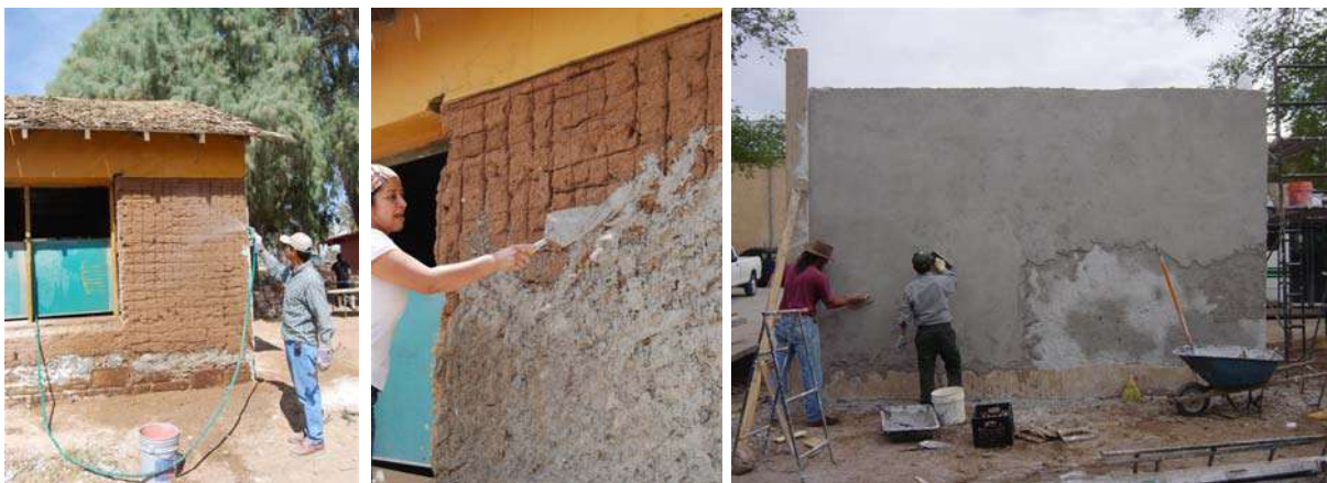
Figura 6 – Humectación previa; aplicación de la mezcla con cuchara de albañil; revoque final con la mezcla de cal y arena aplicado con llana
