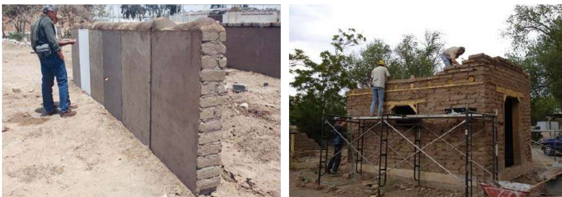
Figura 1 – Muro de trabajo para los talleres (a la izquierda) y limpieza del edificio antes de aplicar el revoque
