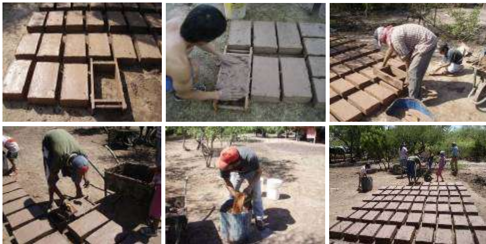
Figura 5 – Etapas de moldeado de los adobes (Rotondaro et al, 2009)
