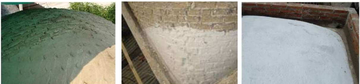
Figura 14 – Bóveda con lechada de cal y arena
