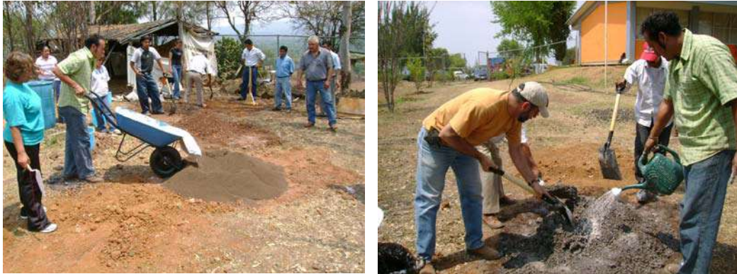
Figura 5 – Mortero de cal y arena: agregado de cal en pasta y humedecimiento progresivo de la mezcla
