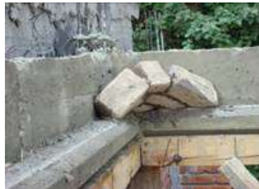
Figura 9 – Colocación de la tercera hilada, ajustando a la pieza del centro
