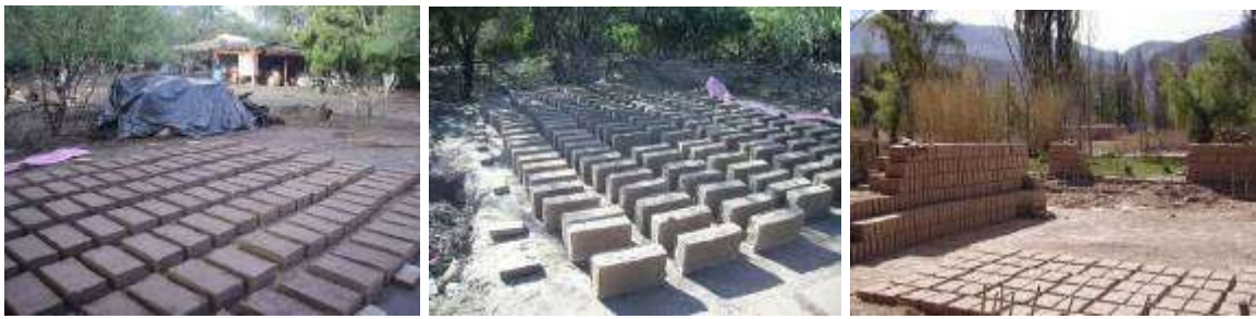
Figura 7 – Etapas de secado y acopio de adobes
