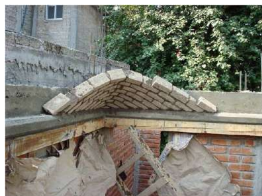
Figura 10 – Asentamiento a partir de la quinta hilada de BTC
