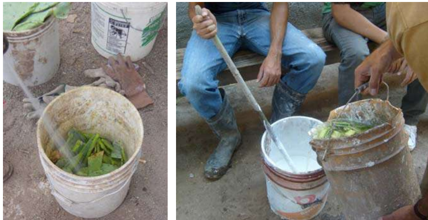
Figura 7 – Macerado de nopal. Agregación y mezcla del mucílago en una cubeta llena hasta la mitad con pasta de cal
