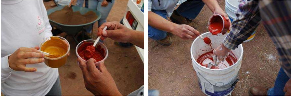
Figura 8 – Hidratación de pigmentos para la pintura y su mezcla a la cal
