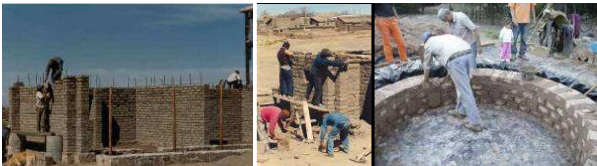
Figura 8 – Construcción de paredes de adobe (Rotondaro et al, 1998; 2009)
