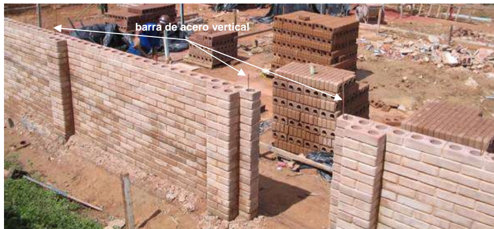
Figura 8 – Albañilería de BTC con huecos y juntas de mortero con barras de acero verticales para refuerzo de la pared
