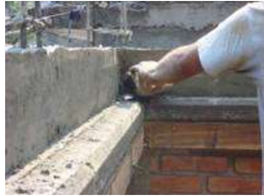
Figura 7 – Colocación del primer BTC
