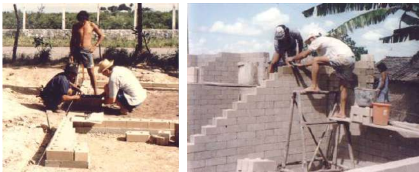
Figura 7 – Ejecución de paredes con BTCs
