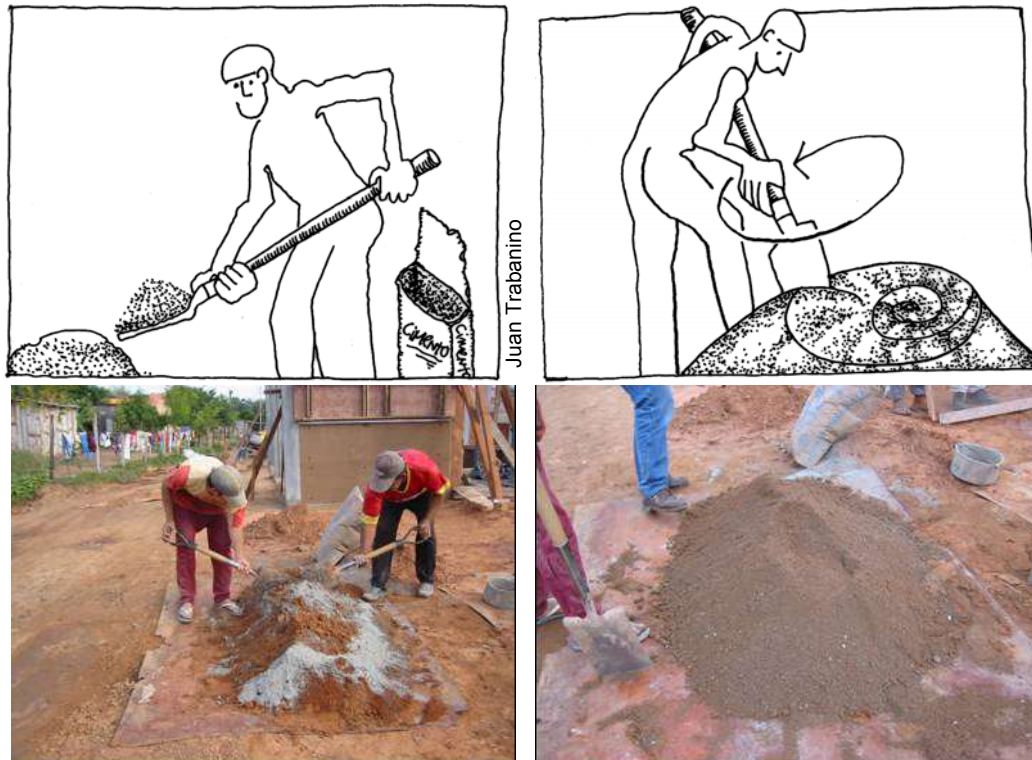
Figura 3 – Preparación de la mezcla de suelo y cemento
