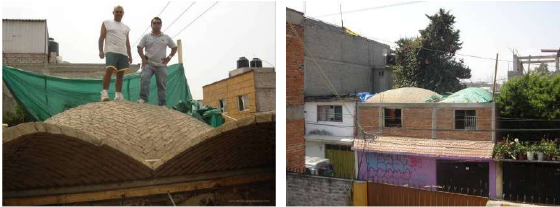
Figura 17 – Bóvedas de la Casa Santo Domingo terminadas
