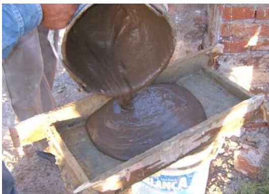
Figura 2 – Consistencia del mortero de colocación del BTC
