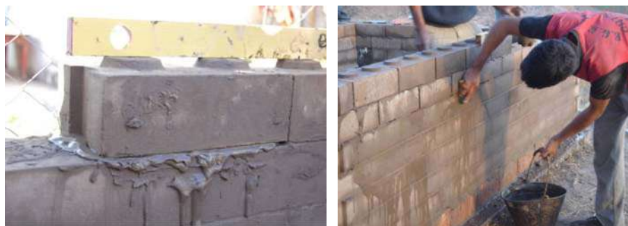
Figura 9 – Albañilería de bloque Mattone con mortero fluido y limpieza de la superficie
