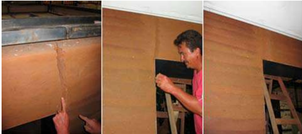
Figura 9 - Consolidación de grietas en el panel monolítico
