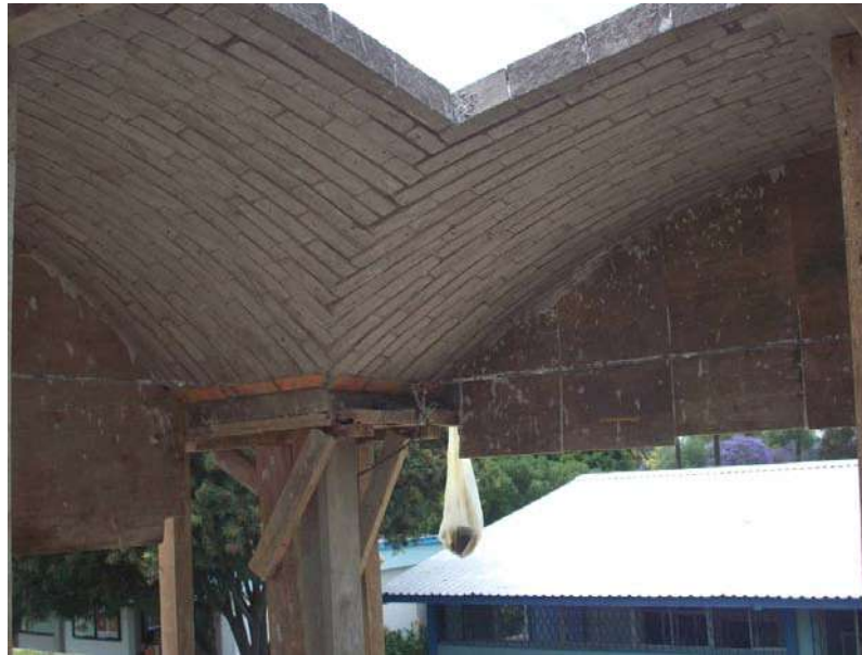
Figura 1 – Ejemplo de bóveda de adobe, en ejecución
