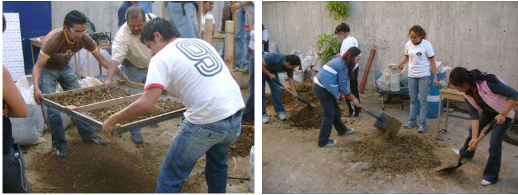
Figura 2 – Tamizado de la tierra y mezcla de la paja con la tierra
