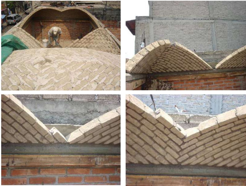
Figura 11 – Término de pechinas y cuatrapeo de BTC para iniciar cerramiento de bóveda
