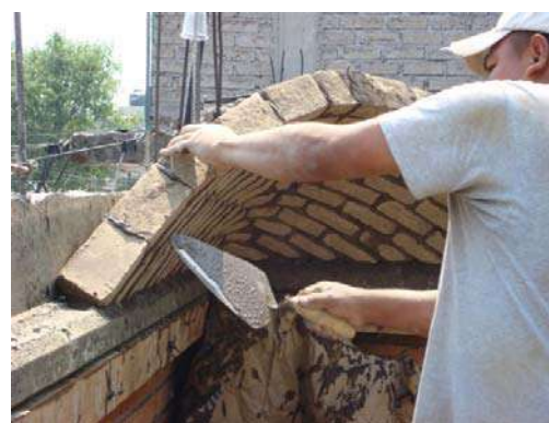
Figura 10 – Asentamiento a partir de la quinta hilada de BTC
